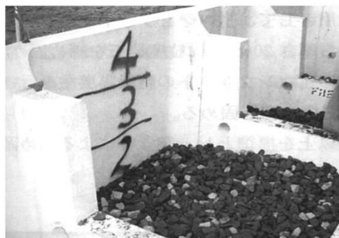
Рисунок 16 - Выровненный слой щебня внутреннего заполнения
