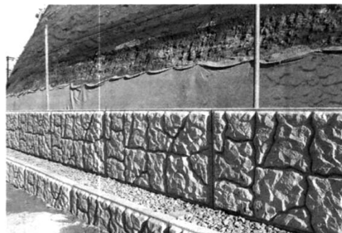
Рисунок 18 - Установка второго ряда
