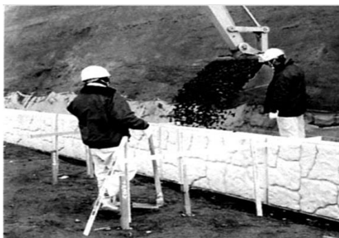
Рисунок 15 - Засыпка заполнителя
